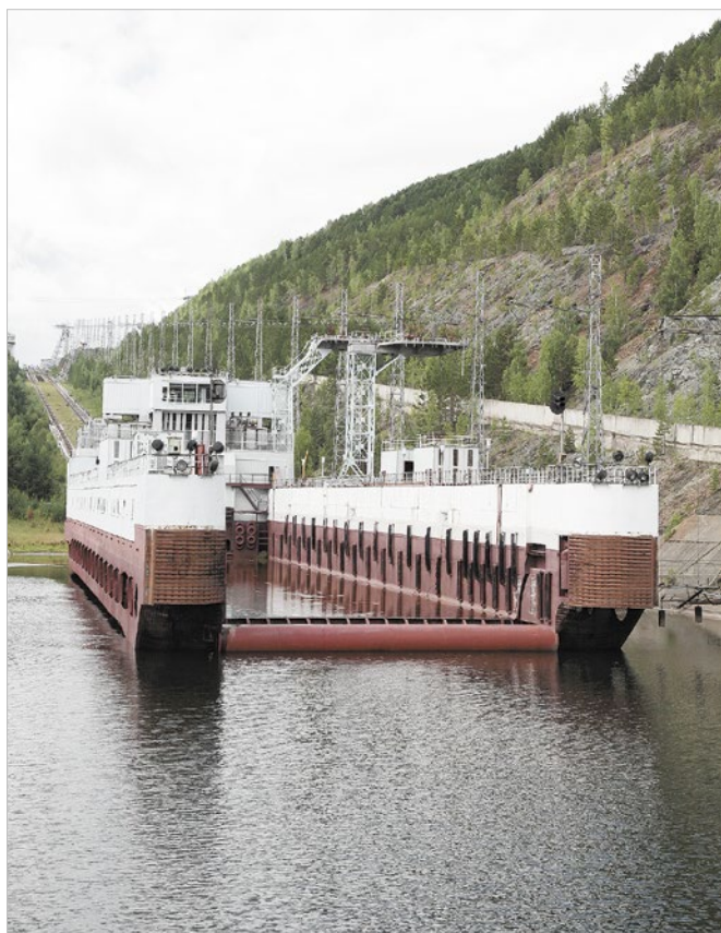
Судоподъемник на Красноярской ГЭС – единственный в России механизм для подъема судов через гребень гидроэлектростанции
