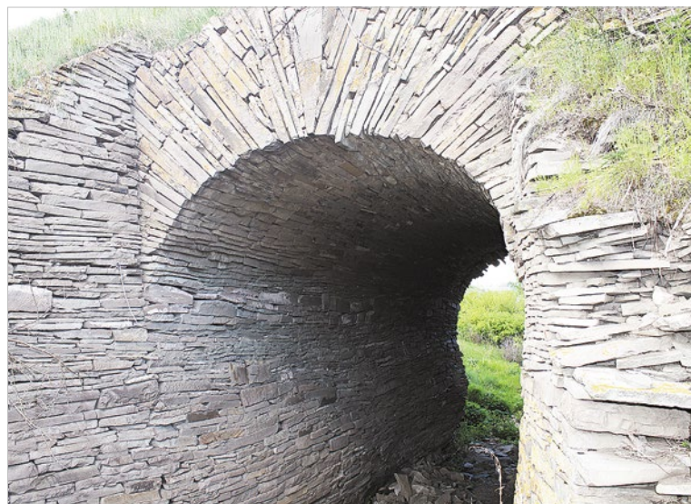
Этот каменный мост, сложенный без единой капли цементного раствора, – редкость не только для Сибири, но и для всей России
